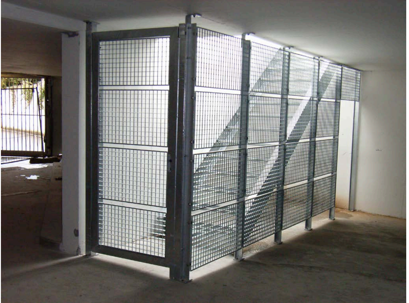
Abtrennung Tiefgaragen / Treppe
