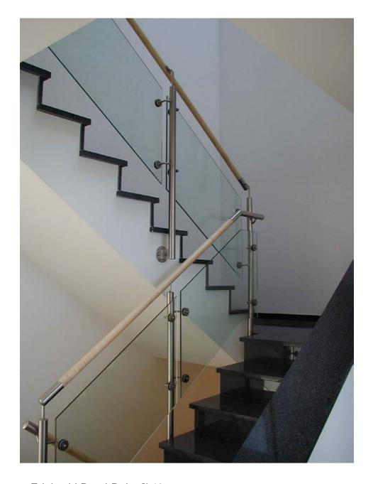
Pfosten: Edelstahl Rund-Rohr Ø 42mm
