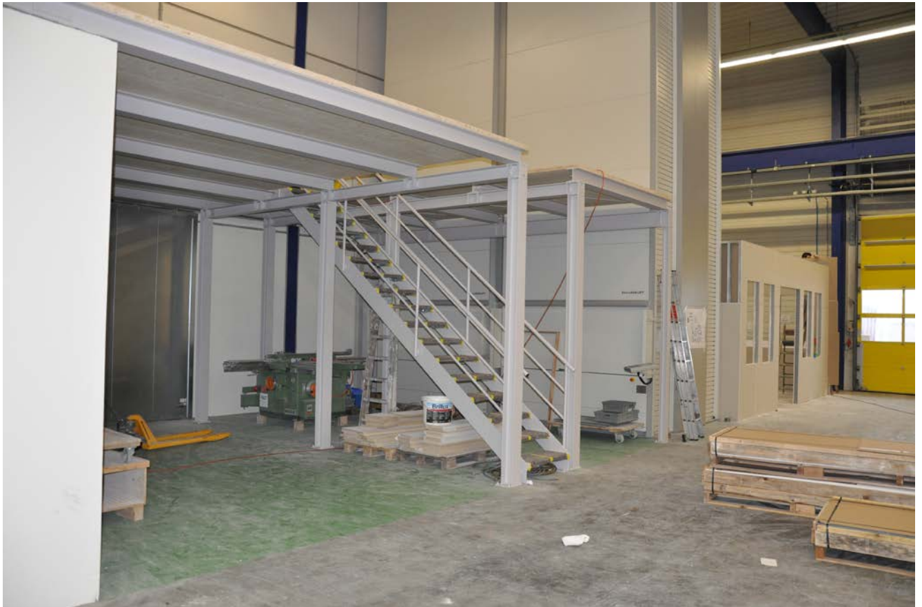
Zwischenboden mit Treppe
